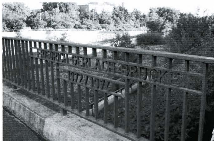
Heute sinnlos erscheinende Brücke über eine virtuelle Autobahn
