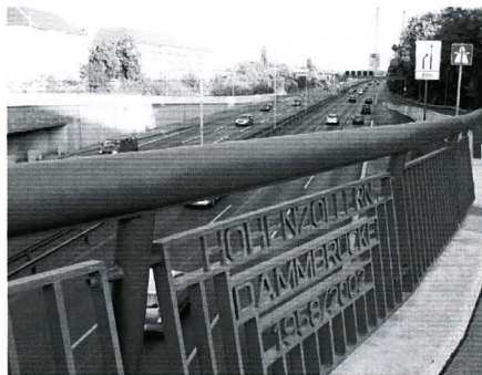
Eine der ältesten Stadtringüberquerungen mit Zufahrten von 1958–2002 komplett erneuert
